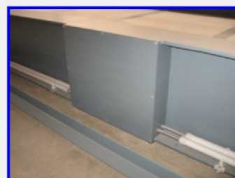
Nagersicherer Kabelschutz
